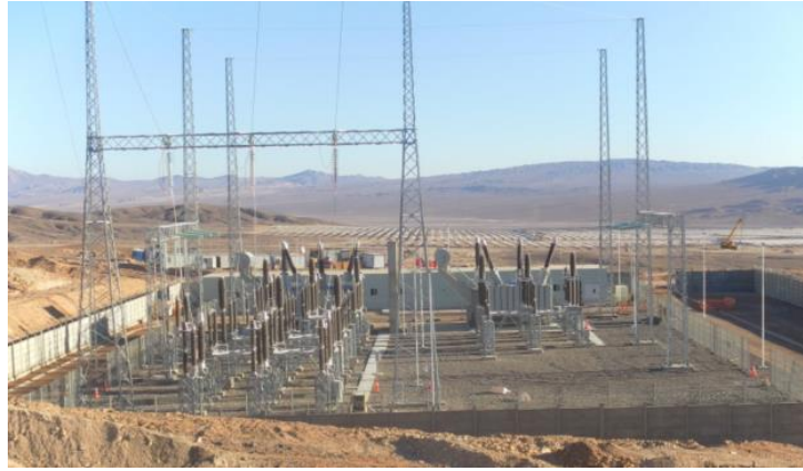
Şekil 6. Şalt Binasının Yapımı.
