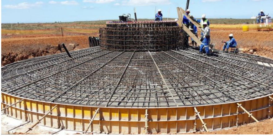
Şekil 5. Türbin Temel Çalışması.
