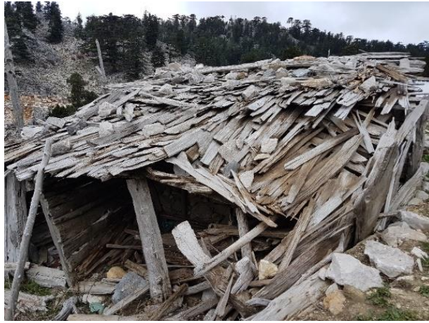
Şekil 13. Salamut Yaylası’nda bir obanın yongalı çatısı (Akkaya, 2019)
