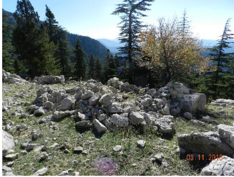
Şekil 15. Çataloluk mevkinde yer alan metruk yapı
