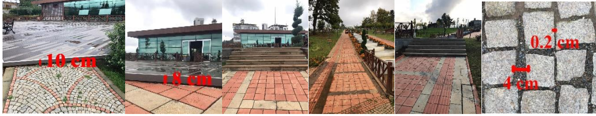
Resim 3. % 17 eğime sahip yaya yolu (1 nolu yaya yolu), yan yol bağlantıları ve derz aralıkları
