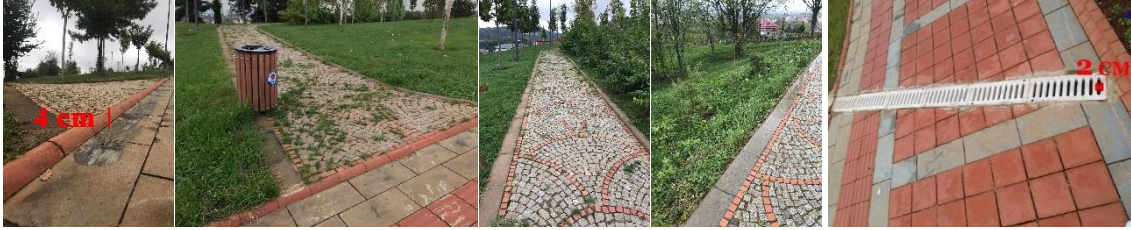
Resim 4. Yürüyüş yolları birleşimindeki kot farkı, bordür ve ızgara uygulaması
