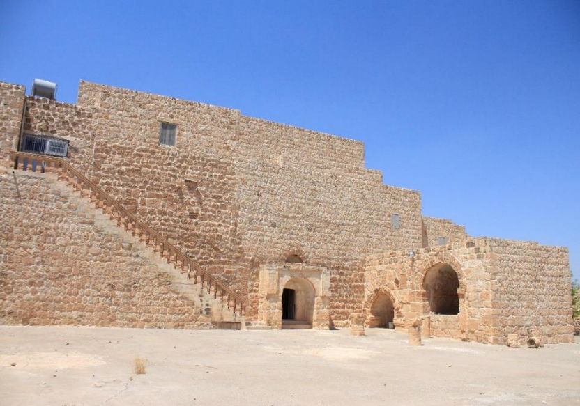
Fotoğraf 2: Mor Kuryakos Kilisesi güney cepheden genel görünüm.
