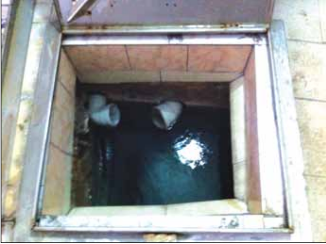
Şekil 4. İnegöl-Oylat kaplıcası kaynağı.
