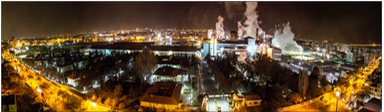
Şekil 4. Konya Şeker Merkez Kampüsü -gece görünüm (Url 6)
