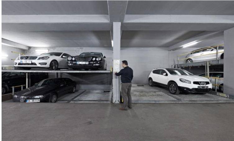
Şekil 3. Kuyulu bağımsız tip mekanik otopark çözümü Zühtü Tursan Apartmanı, Kadıköy İstanbul (Otomatik, 2019c).
