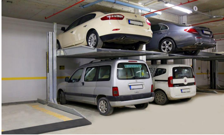
Şekil 2. Bağlı tip mekanik otopark çözümü Lale Apartmanı, Etiler İstanbul (Otomatik, 2019b).
