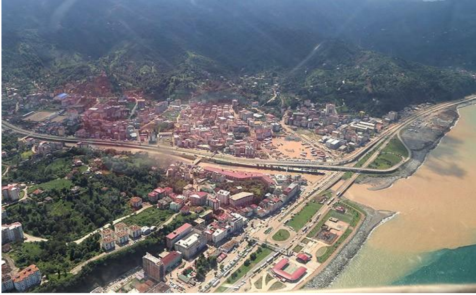
Şekil 2. Hopa şehir merkezi ve Sundura Mahallesi'nin sel ve taşkın sonrası durumu (2016).
