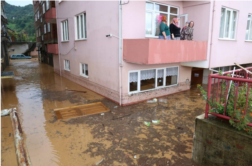
Şekil 5. Arhavi Hacılar Mahallesi sel ve taşkın sonrası alt yapı yetersizliğinin görüntüsü (2015).
