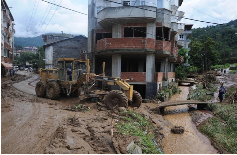
Şekil 4. Hopa Sugören Köyü dere içine yapılan evlerin sel ve taşkın sonrası görüntüsü (2016).
