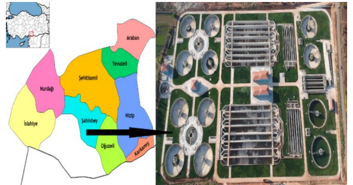
Şekil 4. Gaziantep İli ve Gaziantep Merkez İleri Biyolojik Atıksu Arıtma Tesis
