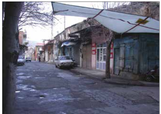
Fotoğraf 5 - Restorasyon öncesi güney cephesi / Southern façade before restoration.
