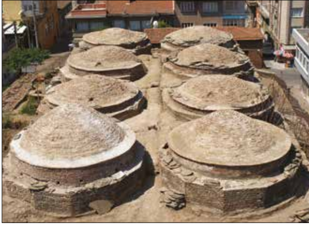
Fotoğraf 19 - Restorasyon çalışmaları sırasında çatı / Roof during restoration works.
