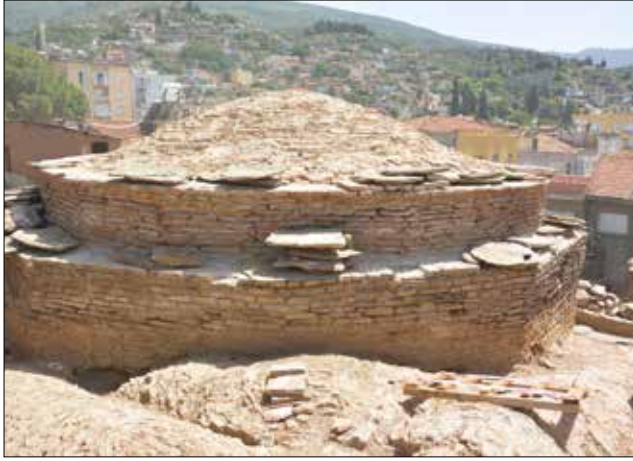
Fotoğraf 20 - Restorasyon çalışmaları sırasında kubbelerden / Domes during restoration works.
