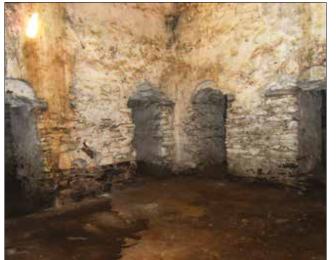
Fotoğraf 10 - Restorasyon öncesi ana mekânın güneydoğu köşesindeki depo hücreleri / Warehouse chambers on the southeastern corner of the main hall.
