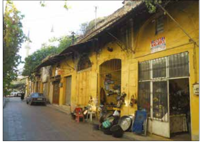
Fotoğraf 4 - Restorasyon öncesi kuzey cephesi / Northern façade before restoration.
