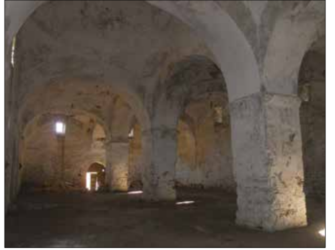
Fotoğraf 9 - Restorasyon öncesi ana mekânın doğudan genel görünüşü / Main hall from the east before restoration.
