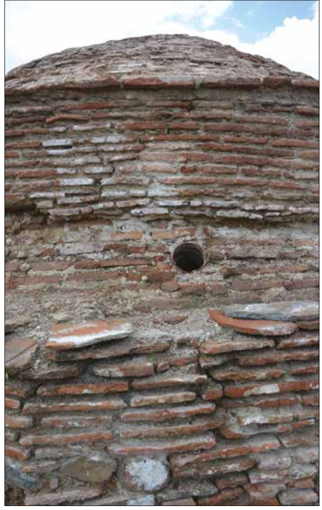
Fotoğraf 21 - Restorasyon çalışmaları sırasında kubbelerden / Domes during restoration works.
