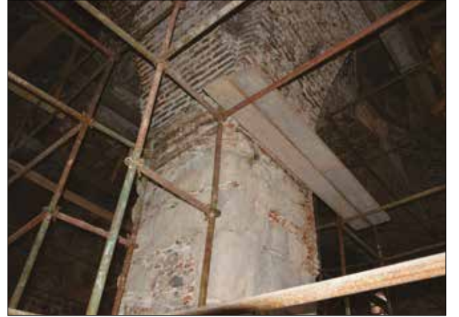
Fotoğraf 18 - Restorasyon çalışmaları sırasında ayaklardan görünüş / View from pillars during restoration.
