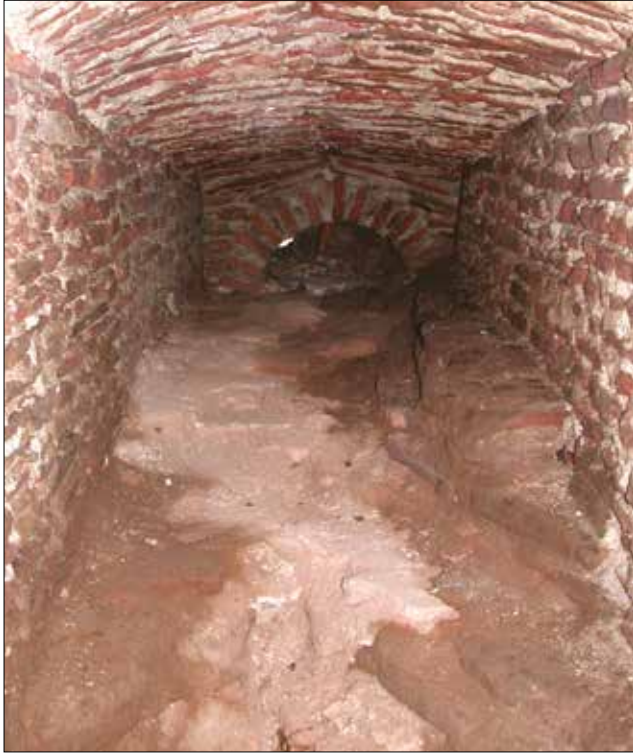
Fotoğraf 26 - Kubbeler arasındaki beşik tonozla örtülü dehliz / The gallery with barrel vault between the domes.
