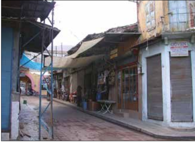
Fotoğraf 2 - Restorasyon öncesi doğu cephesi / Eastern façade before restoration.
