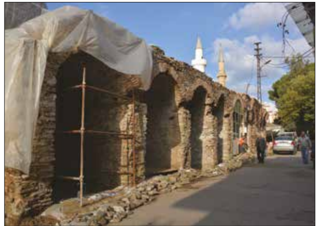
Fotoğraf 11 - Restorasyon çalışmaları sırasında güney cephesi / Southern façade during restoration works.
