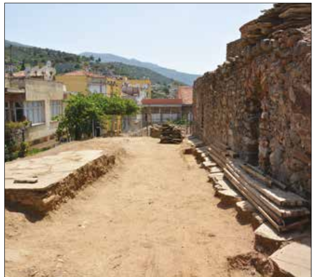
Fotoğraf 22 - Dükkânların üzerindeki toprak dolgu / Earthfill over the shops.
