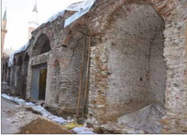
Fotoğraf 12 - Restorasyon çalışmaları sırasında kuzey cephesi / Northern façade during restoration works.
