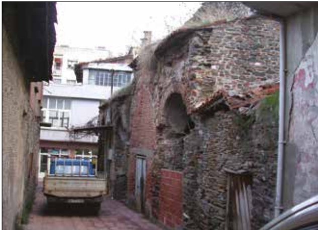
Fotoğraf 3 - Restorasyon öncesi batı cephesi / Western façade before restoration.
