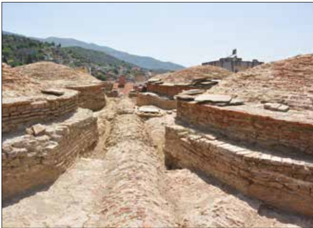
Fotoğraf 23 - Çatıda kubbeler arasındaki dehlizi örten tonoz / Vault covering the gallery on the roof between the domes.
