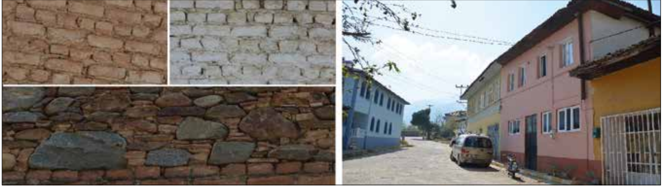
Fotoğraf 7. Yapı yüzeylerinde doku ve renk çeşitliliği / Texture and Color Diversity on Building Facade
