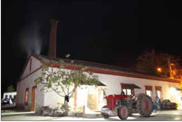
Fotoğraf 7: Sağancı Köyü'nde bulunan zeytinyağı fabrikası görünüşü (Bergama) / The front façade of olive oil mill in Sağancı village
