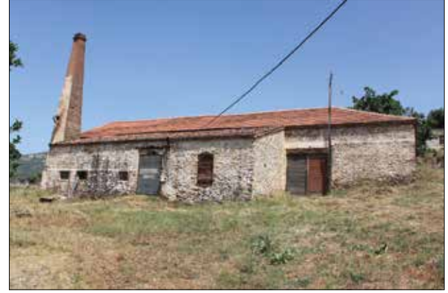
Fotoğraf 6: Birgi'de bulunan zeytinyağı fabrikası görünüşü (Ödemiş, İzmir) / The front façade of olive oil mill in Birgi
