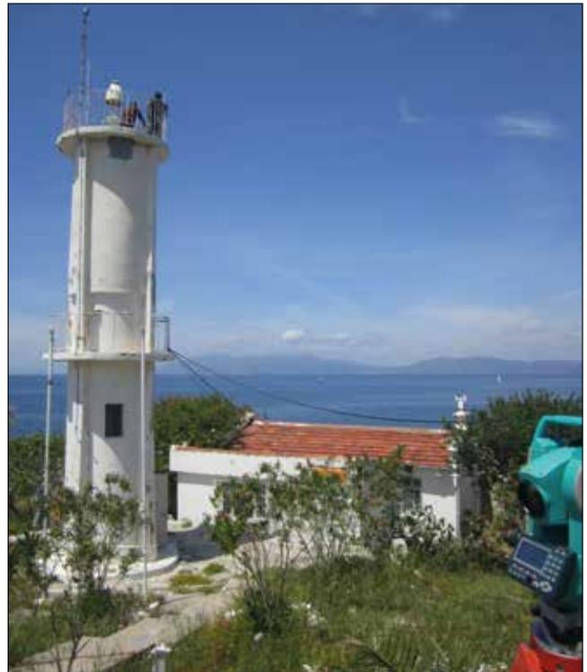
Figure 13. Aydın Güvercinada Lighthouse which had been knocked down twice due to storms and partially had been reconstructed, (Başağaç 2012) and (Başağaç 2018: 112). / *Aydın Güvercinada Deniz Feneri'nin ışık kulesi fırtınalar yüzünden iki kez yıkılmış ve kısmen yeniden inşa edilmiştir. (Başağaç 2012) ve (Başağaç 2018: 112).*
