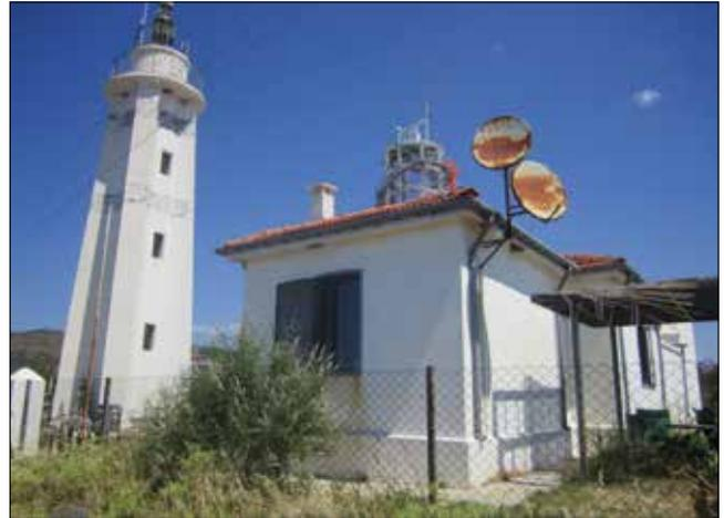
Figure 6. Sivrice Lighthouse in Ayvacı, Çanakkale had a light tower within the keeper's residence until 1945. Today it has an independent concrete light tower, (Başagaç 2012). / Çanakkale Ayvacı'ya bulunan Sivrice Deniz Feneri'nde ışık kulesi 1945 yılına kadar bakıcı konutu içerisinde yer almıştır. Bugün ise bağımsız beton bir ışık kulesi bulunmaktadır. (Başagaç 2012).
