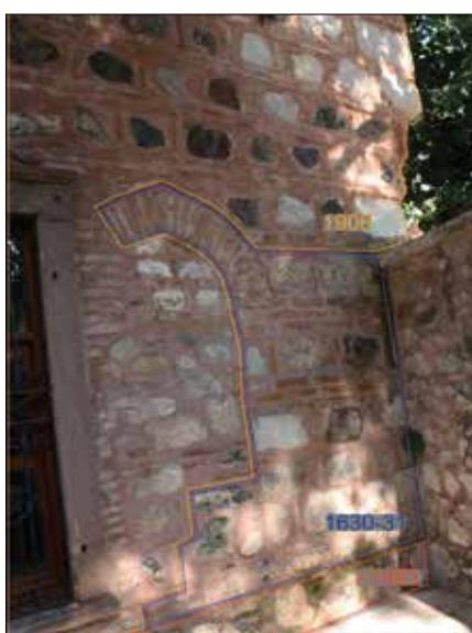
Photo 10 - Three different types of construction technique seen at the western wall of the Prayer Hall / *Harim batı duvarında görülen üç farklı yapım tekniği.*
