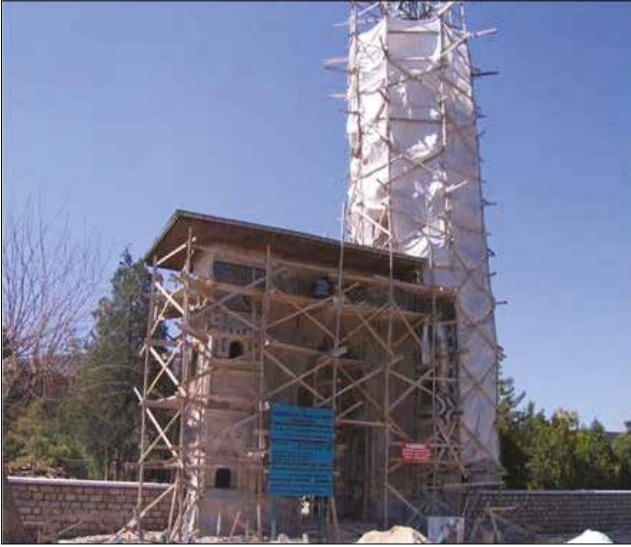
Fotoğraf 11 - Sahip Ata Camii taçkapının onarım sırasındaki görünüşü (2007) / The view of the portal during the restoration (2007)
