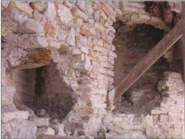
Fotoğraf 14 - Taçkapının arkasında, minare kapıları seviyesinde duvarda açılan bölüm, detay (2007) / The distructed portion at the level of the minaret doors, behind the portal, detail (2007)
