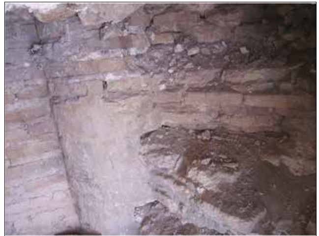
Fotoğraf 16 - Doğu yönde yer alan yıkılmış minarenin merdiven çekirdeği ve tuğla örgülü basamaklar (2007) / Inside of the east minaret and brick stairs (2007)
