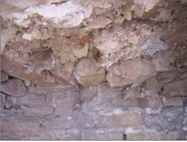
Fotoğraf 17 - Minare yıkıldıktan sonra minare kasasının moloz taş, tuğla ve harçla kapatılan üst kısmı (2007) / The upper side of the demolished (east) minaret which closed with stone, brick and mortar
