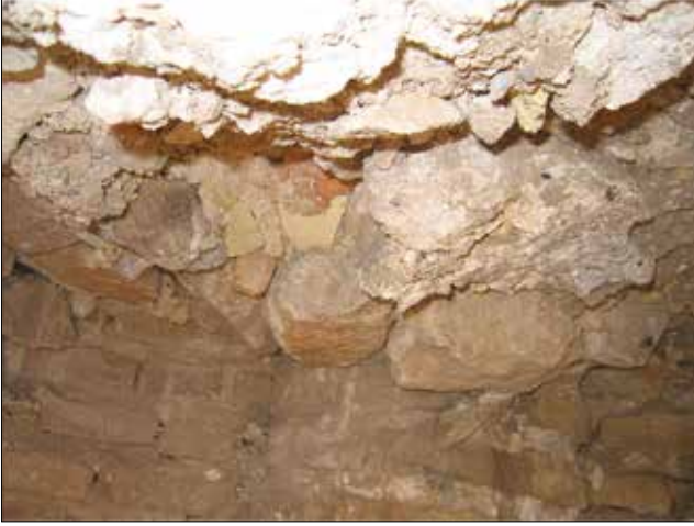
Fotoğraf 18 - Minare yıkıldıktan sonra minare kasasının moloz taş, tuğla ve harçla kapatılan üst kısmı (2007) / The upper side of the demolished (east) minaret which closed with stone, brick and mortar
