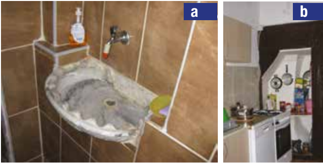
Fotoğraf 9 - Birlik Sokak, No:3 (a) özgün hamamdan taşınan bir parça günümüzde tuvalette lavabo olarak kullanılmakta; (b) mutfakta dönüştürülmüş dolap / Birlik Street, No:3 (a) the reuse of the original hammam basin as the hand basin the toilet; (b) The conversion of the traditional cupboard in the kitchen
