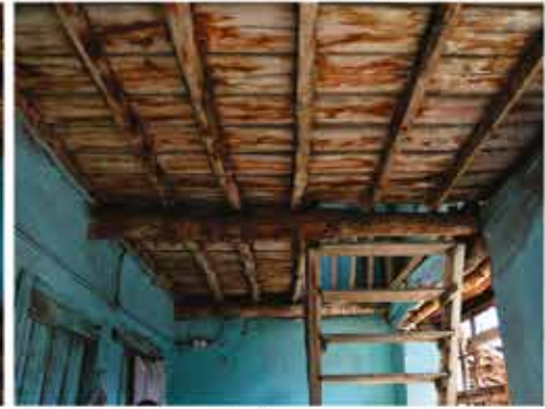
Foto. 39: Batı cephesi Photo. 39: West elevation
