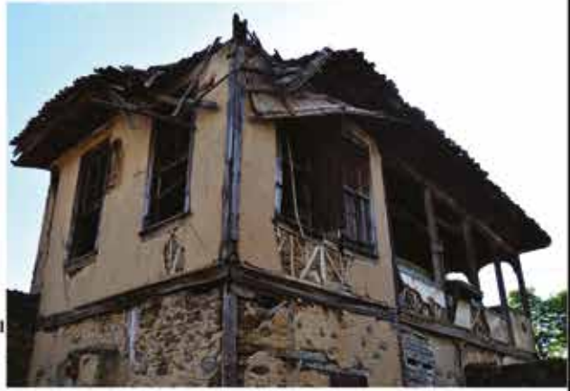
Foto. 21: Batı cephesi Photo. 21: West elevation
