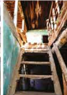
Foto. 27: Merdiven Photo. 27: Stair
