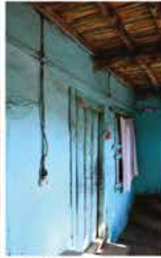
Foto. 38: Batı cephesi Photo. 38: West elevation
