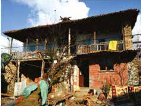
Foto. 30: Güney cephesi Photo. 30: South elevation
