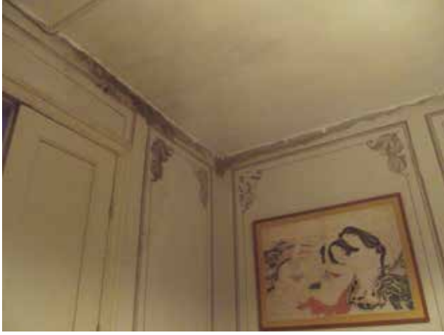
Fotoğraf 11 - 2300 ada 5 numaralı parseldeki yapının iç mekanının Ocak, 2013'teki durumu (Kaynak: Dinler, 2013) / The situation of the interior of the building on the building block 2300 the building lot 5 in January, 2013 (Source: Dinler, 2013)
