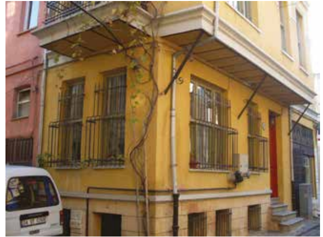
Fotoğraf 6 - 2307 ada 28 parseldeki yapının restorasyon sonrasındaki durumu (Kaynak: Dinler, 2013) / The after-restoration situation of the building on the building block 2307 the building lot 28 (Source: Dinler, 2013)
