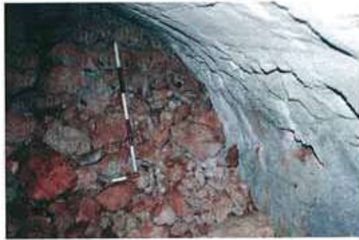
Res. 8. Bizans devrine ait tonozlu yapının sıvalı iç kısmı.
