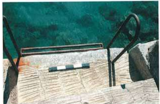
Res. 28. İskele mevkiinde, beton iskeledeki devşirme taşlar.
