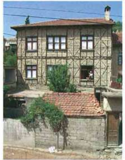
Res. 28. Ahşap karkas tekniğinde yapılmış bir ev örneği: Ahmet Tan evi (env. no: O23.B8.11).
