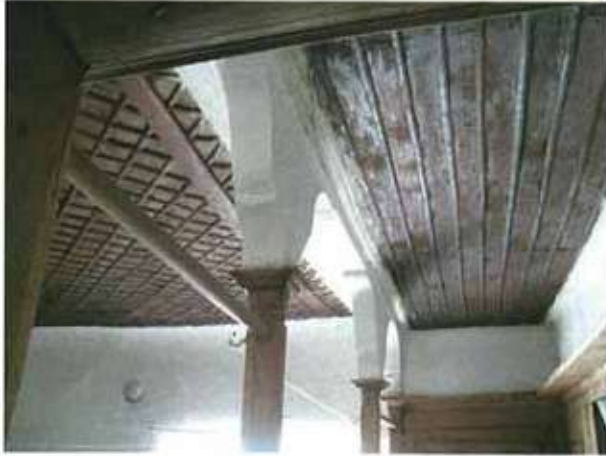
Res. 21. Fethiye Caddesinde Sıdika Acar evinde (env. no: O23.B8.5) seki altı ve seki üstü tavanları.
