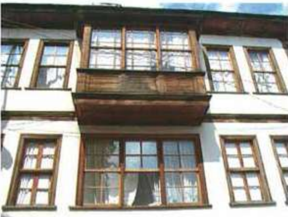
Res. 29. O. Nuri Çınar evinin (env. no: O23.B8.53) yola bakan cephesi.
