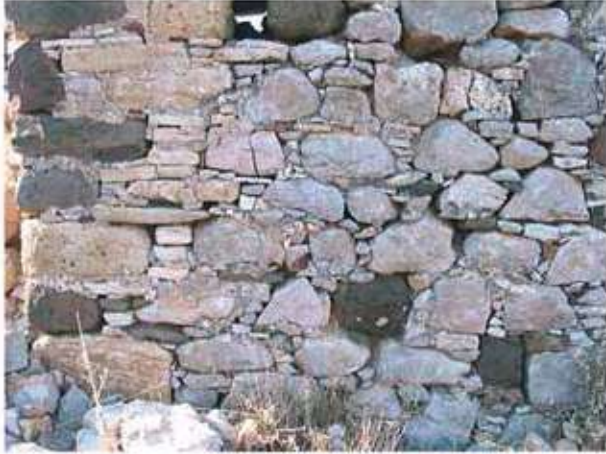
Res. 19. Çullu köyü, konut duvar örgüsü, ayrıntı.
