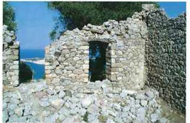
Res. 12. Hisarcık köyü camisi (env. no: K16.C5.51), harım.
