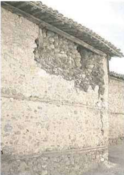
Res. 21. Cephede sac kaplama ve sıvasız duvar (env. no: L21B1227), Helvacılar Mahallesi.
