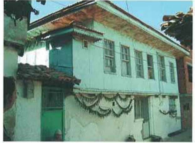
Res. 26. Saçak kenarındaki sac malzemede bezeme örneđi.
