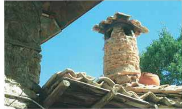
Res. 36 - 37. Buldan'ın baca örneklerinde, çoğunluğunda birer tuğlanın basamaklı olarak dışarıya taşınmasıyla elde edilen bir biçimlenme dikkat çeker.
