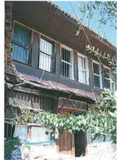
Res. 20. Cephede sac kaplama kullanımına bir örnek (env. no: L21B1075), Turan Mahallesi.
