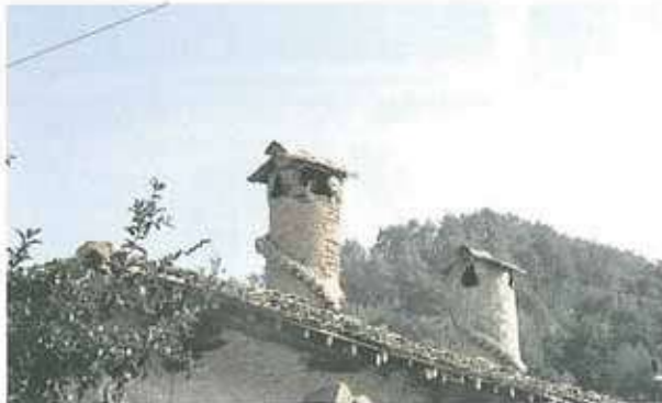
Res. 36 - 37. Buldan'ın baca örneklerinde, çoğunluğunda birer tuğlanın basamaklı olarak dışarıya taşınmasıyla elde edilen bir biçimlenme dikkat çeker.
