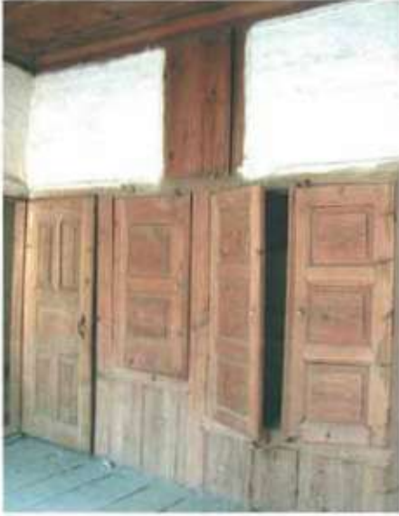
Res. 60. Oda kapıları açıldığı yönde yer alan duvarın üzerinde bir girinti oluşturulur, kapı bu girintiye oturur (K22B0030 env. numaralı konut).
