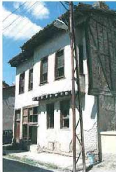
Res. 37. Dışarı taşan döşeme kirişlerine oturtulan, altı kaplamasız çıkma (env. no: K22B030).
