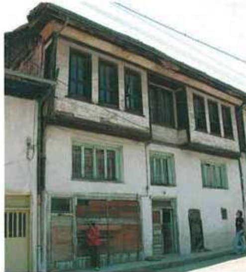
Res. 43. Altı dükkân üst katları konut olarak kullanılan bir yapı (env.no: K22B066).
