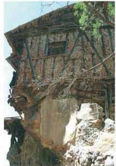
Res. 38. Kaya oluşumu ile yapı duvarının birleşmesine örnek.
