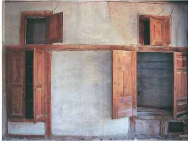
Res. 63. Duvarın solunda yer alan yükük ve sağında yer alan yıkanma dolabı (gusulhane).
