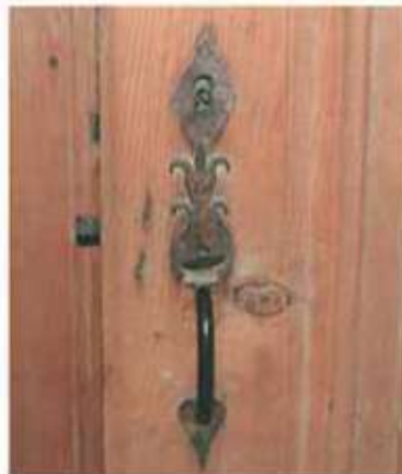
Res. 64. Oda kapısının kapı kolu ayrıntısı (en solda).
