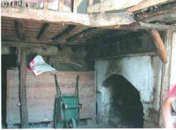
Res. 54. Yapıların zemin katında yer alan avlu ve ocaklık (K22B0044 env. numaralı konut).
