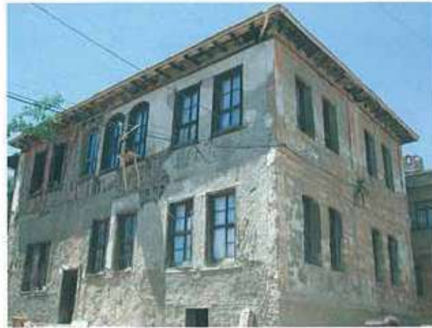
Res. 49. Ahşap karkas yapının dışına yığma tuğla ikinci bir duvarın örülmesi uygulaması (env. no: K22B0038).
