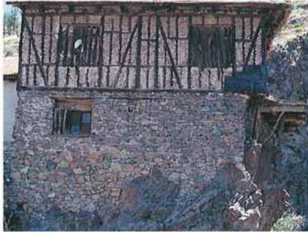
Res. 34. Kayalık zeminde, kayaların kısmen duvar olarak kullanıldığı bir yapı.
