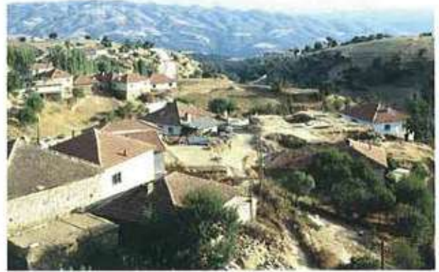
Res. 2. Karaköy (env. no: L21C011) Merkez Mahallesinden genel görünüm.
