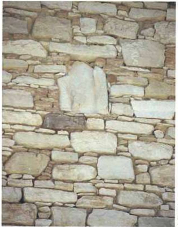
Res. 45. Celal Çamoğlu evinin (L21C009.005) duvarında kullanılan devşirme taşlar, Çağış Mahallesi, Buldan.
