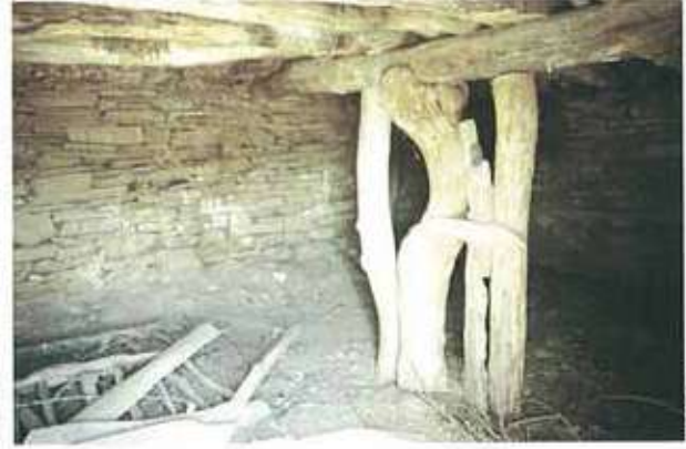
Res. 5. Aynı evin (env. no: L21C011.003) ahırındaki orta dikme.
