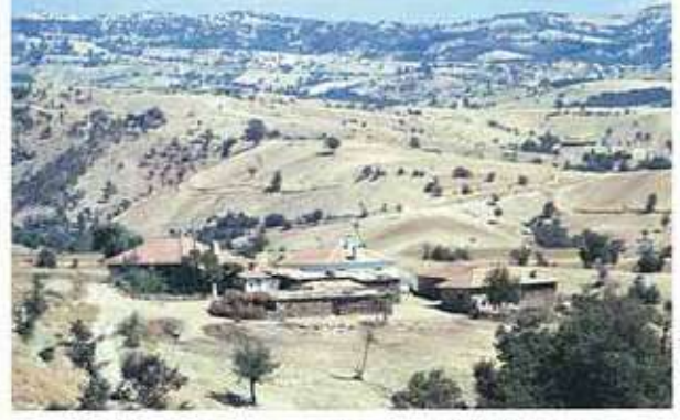
Res. 50. Ramazan Acar evi (env. no: L21C011.042), Aşağı Mahalle, Karaköy.
