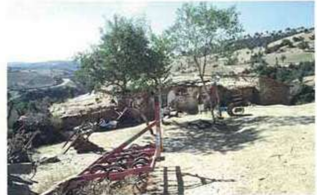
Res. 56. Karaköy, Aşağı Mahallede yol üzerinde bir bağ evi (env. no: L21 011.010).
