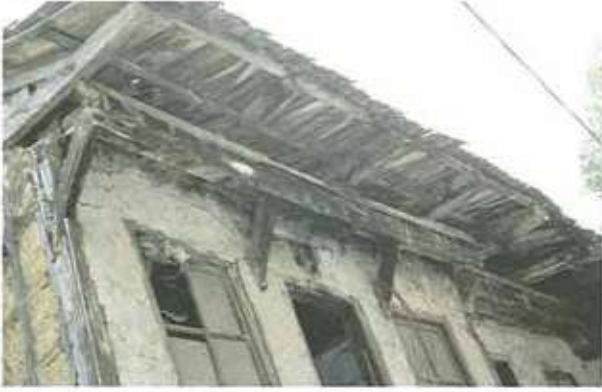
Res. 47. Katı indirilmiş bir yapıda saçaktan ayrıntı (env. no: H22C001.034).
