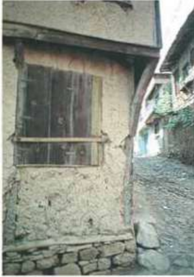
Res. 37. Bakkalı ev örneği (env. no: H22C001.060).
