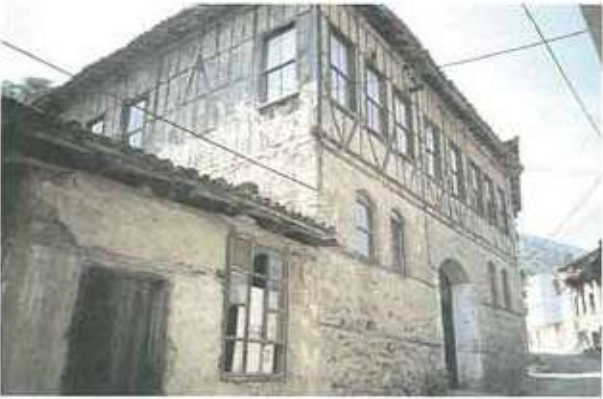
Res. 19. Tuğla dolgulu ahşap karkas yapı (env. no: H22C001.015).
