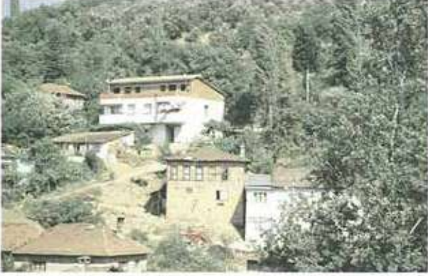
Res. 49. Köy içinde yeni betonarme yapılar.
