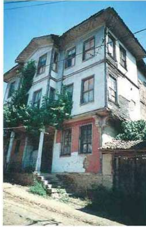
Res. 22. Halil Ağa Konağı (env. no: H22C001.068), genel görünüm.
