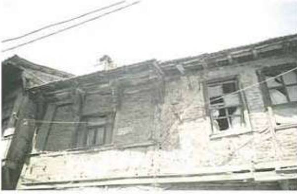
Res. 45. Katı indirilmiş bir yapıda saçaktan ayrıntı (env. no: H22C001.035).
