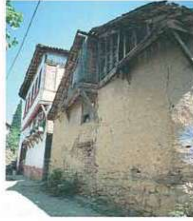
Res. 46. Katı indirilmiş bir yapıda saçaktan ayrıntı (env. no: H22C001.064).
