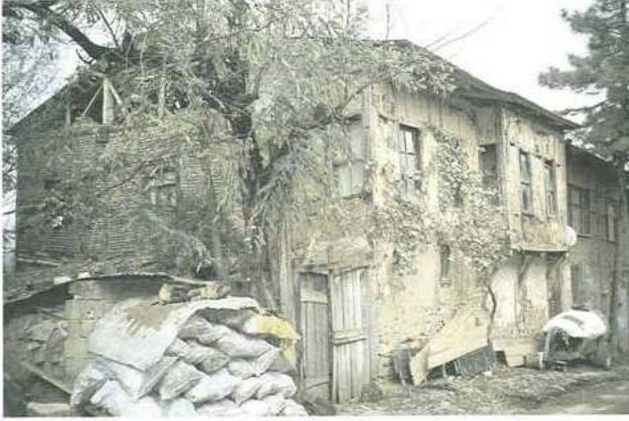
Res. 53. H22C001.092 envanter numaralı yapının sokak cephesi.
