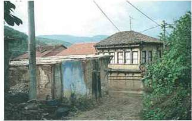
Res. 26. H22C001.066 envanter numaralı yapının kuzeyden görünümü (Kasım 2003).
