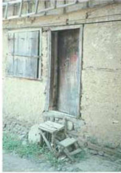
Res. 38. Bakkalı ev örneği (env. no: H22C001.078).
