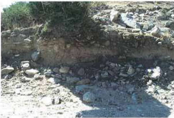
Res. 18. Boğazçiftlik, Sülüler Hayranbağları Zeytinli Akburunönü'nde (env. no: L21A086) sel yüzünden tahrip olmuş bir Bizans Devri yapısına ait kalıntılar görülmektedir.
