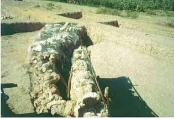
Res. 1. Birecik'in 2 kilometre kadar güneyindeki Mezraa Teleilat Höyüğünde (env. no: O39A002) ortaya çıkartılan taşkın koruma yapısı.
