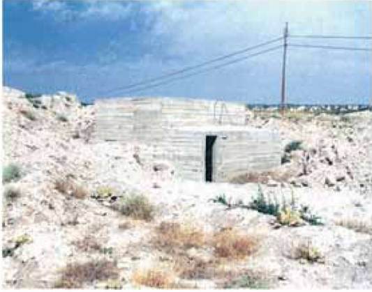
res. 1: Gökçe Kısık Frig Yerleşmesi. Su deposu.
