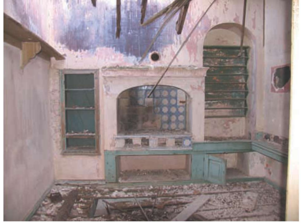
Res. 26. Evlerin mutfakları, bazen orta katta da bulunmaktadır. evlerin esas yaşam katı olarak tasarlanan orta katlarındadır. Müjdat Soylu Evi (env. no: J17.B12.262), Cumhuriyet Caddesi no. 63.
