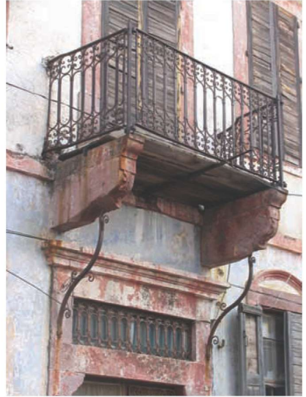
Res. 32. Hüseyin Çelikkaya Evinin (env. no: J17.B12.180) giriş kapısı üzerindeki demir korkuluklu balkonundan ayrıntı. Balkonlar, Cunda evlerinin cephelerine hareket katan unsurlardan biridir.
