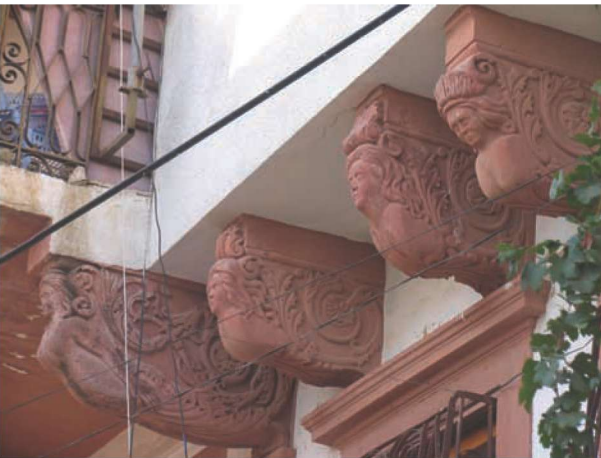
Res. 33. İsmail Gökçen Evinin Sarımsak taşından yapılmış mitolojik figürlü konsolları (env. no: J17.B12.276). Cunda evlerinde balkon kadar yaygın olmamakla birlikte, paraçol veya bezemeli taş konsollarla desteklenen çıkmalar da kullanılmıştır.
