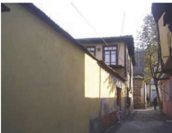
Res. 31d. Mantıcı Okul Sokağı no. 17 (env. no: H22.B17.39), Reyhan Mahallesi.
