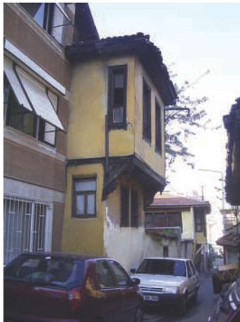
Res. 17e. Reyhan Mahallesi Okul Çıkma Sokağı no.1 (env. no: H22.B17.37).
