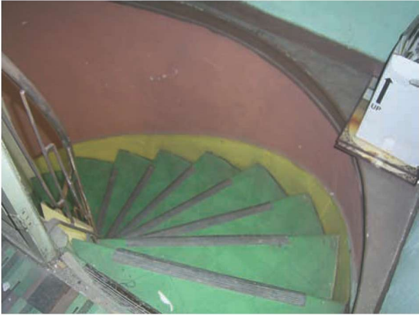
Res. 26. Konutlarda kullanılan ahşap merdivenlere örnek: Reyhan Mahallesi Mantıcı Caddesi no. 11 (env. no: H22.B.17.59).
