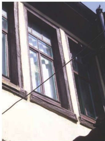
Res. 31e. Tatlı Elma Sokağı no. 18 (env. no: H22.B17.85), Tuzpazarı.
