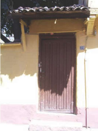
Res. 30d. Mantıcı Okul Sokağı no. 29 (env. no: H22.B17.42), Reyhan Mahallesi.
