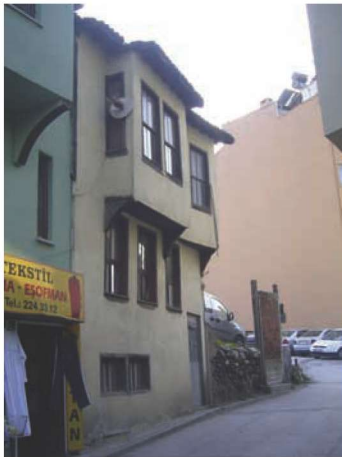
Res. 17d. Tuzpazarı Mahallesi Tayakadın Caddesi no. 22 (env. no: H22.B17.84).
