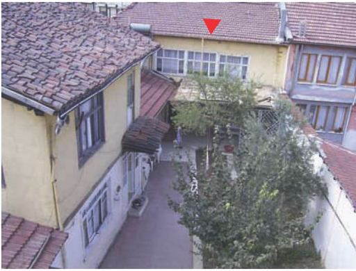
Res. 2. Ön bahçeli konut (env. no: H22.B17.24), Reyhan Mahallesi, Cami Çıkması no. 8.
