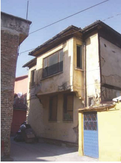
Res. 8. Reyhan Mahallesi, Bekirdede Sokağı no. 24 (env. no: H22.B17.17), cephede çıkma kullanımı.
