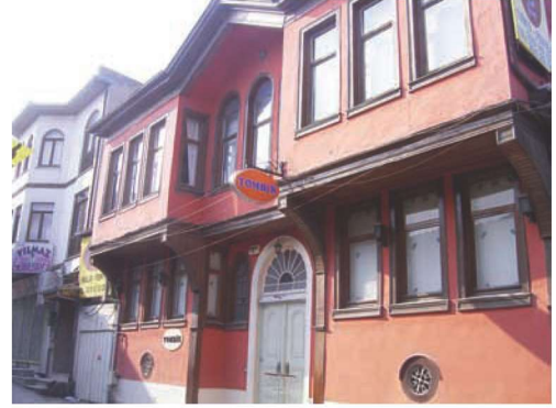
Res. 12. Reyhan Mahallesi, Ürün Sokağı no. 19 (env. no: H22.B17.64) konut.
