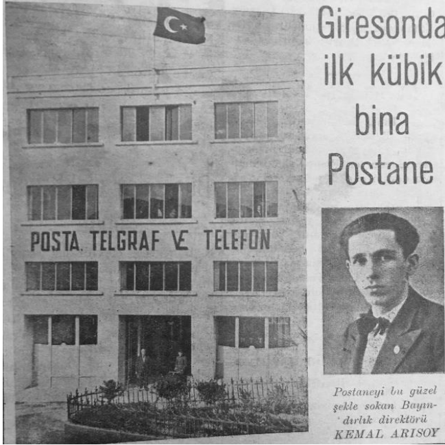
Şekil 6. Yeşilgiresun'da postane binası inşa haberi (Yeşilgiresun Gazetesi Arşivi, 1936)
