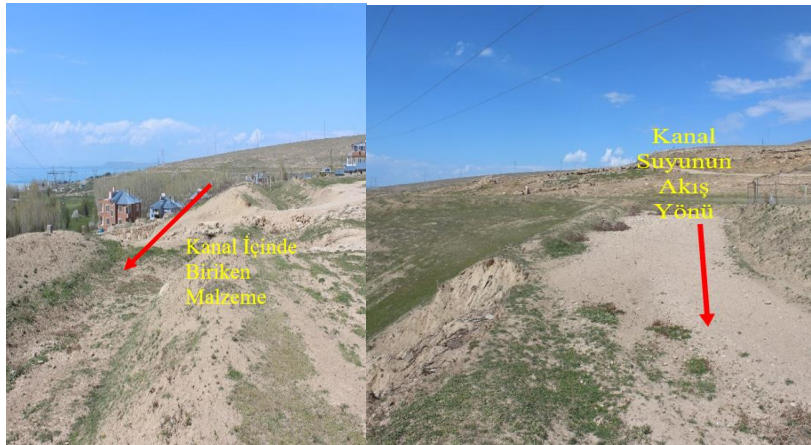
Şekil 3. Tepelik alanlardan akansuyun kanal içinde varattığı tahribat (Oriijinal, 2019)
