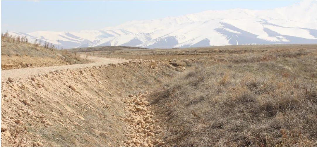
Şekil 8. Yol inşası nedeniyle tahrip olan kuzey kanat ve kanal içerişe dökülen inşaat malzemesi (Orijinal, 2019).
