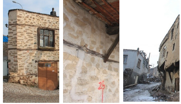
Şekil 7. Geleneksel Sille evlerinde taş, ahşap ve kerpiç kullanımı [26].
