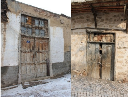
Şekil 5. Sille evlerinde sokağa bakan kapılar [26].
