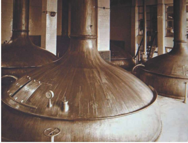
Res.5a- Bomonti Bira Fabrikası son dönem yapıları içerisinde yer alan kazan ve şişe imla elemanları (TEKEL İşletmeleri Genel Müdürlüğü Fotoğraf Arşivi)
