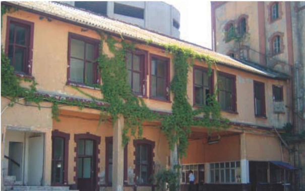
Res.8- B blok yapısı genel görünüm
