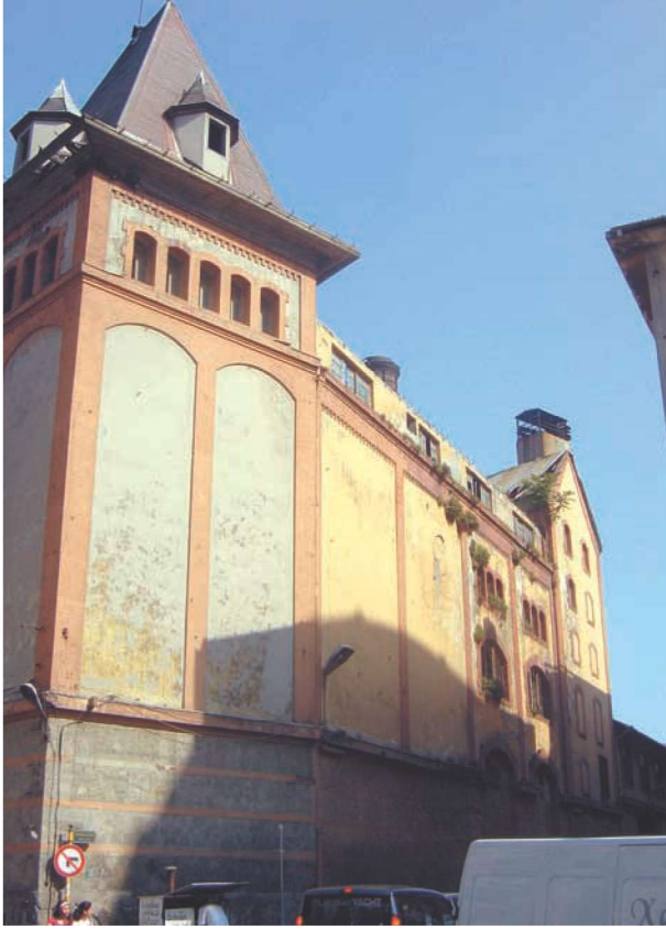
Res.9- C blok yapısı genel görünüm
