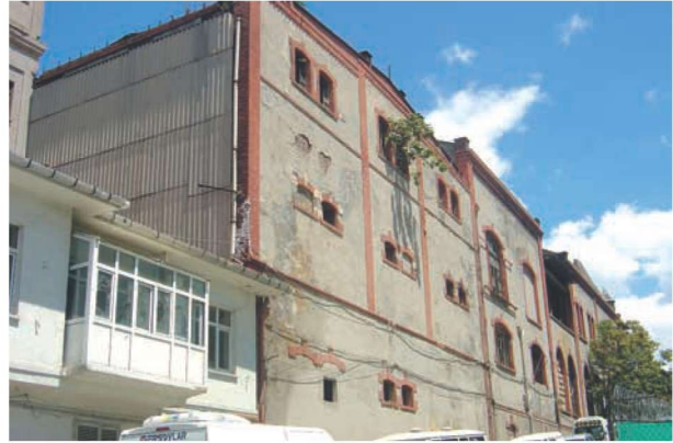
Res.11a- F blok yapısı genel görünüm
