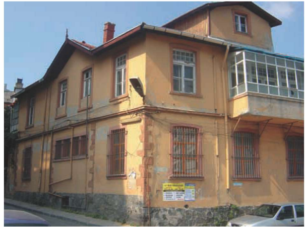
Res.7- A blok yapısı genel görünüm
