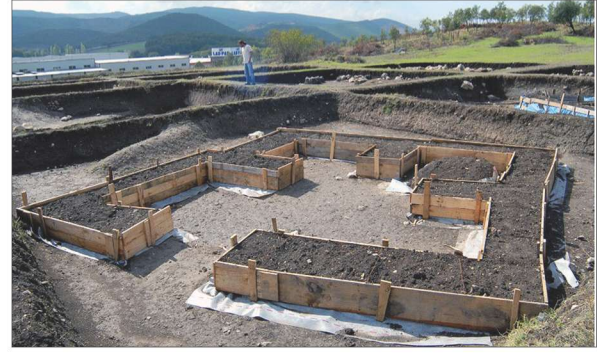
Res. 5. Arkeolojik yapı kalıntılarının ahşap kalıba alınarak korunması
