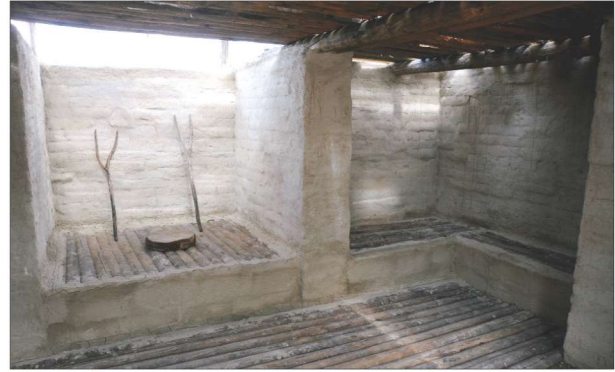
Res. 11. Sıva sonrası kireç badanalama ve tabanların ahşapla kaplanması
