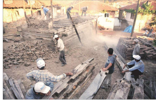
Res. 16. Arkeopark alanına taşınmak üzere sökülmekte olan bir ahşap konut
