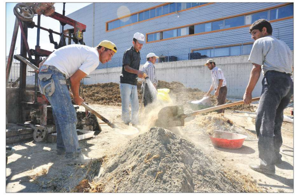
Res. 6. Kalkolitik Dönem canlandırması için gerekli kerpiçin makine ile üretilmesi
