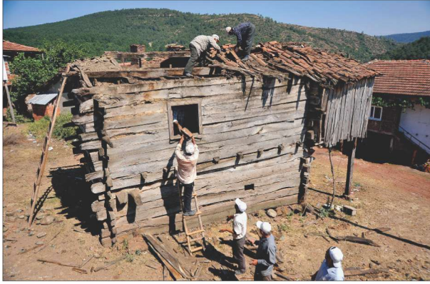
Res. 15. Arkeopark alanına taşınmak üzere sökülmekte olan bir ahşap konut
