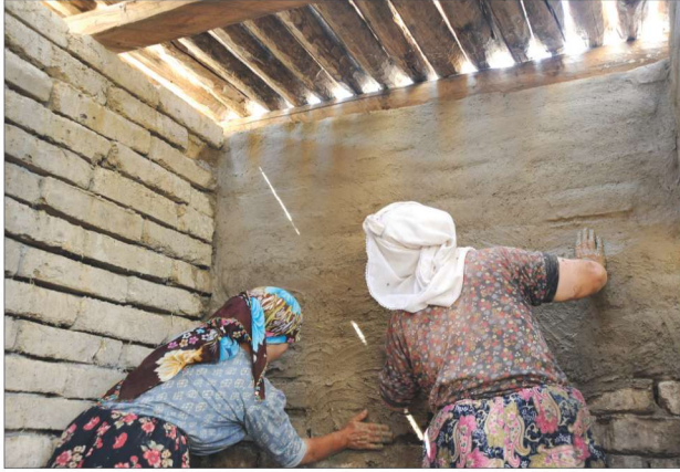
Res. 10. Model evlerin kazı verilerine uygun biçimde yeşil kil ile sıvanması
