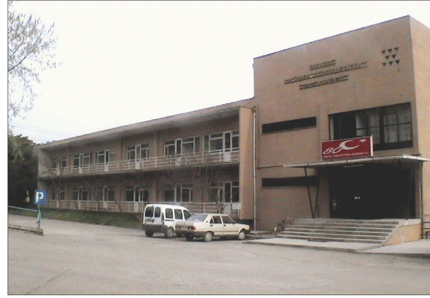
Res. 7. İdare binası (2005)
