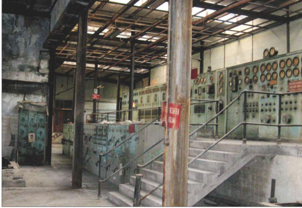
Res. 22. Hamur ünitesinin zemin katı (2008)
