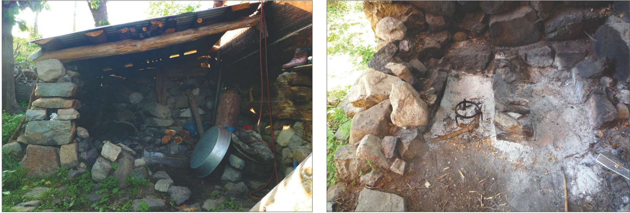
Res. 25. Hoço ve içerisinde yer alan ocak düzeneği
