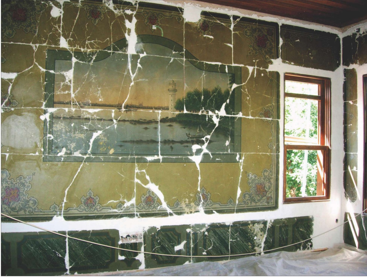
Res. 24a. A yapısı baş odada rekonstrüksiyon sonrasında yerine monte edilen kalemışı panolar
