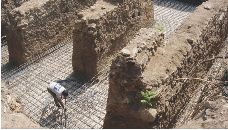
Res. 21a. Sümbüllü Bahçe A yapısı altından çıkan duvarlar ve yapının temel sistemi
