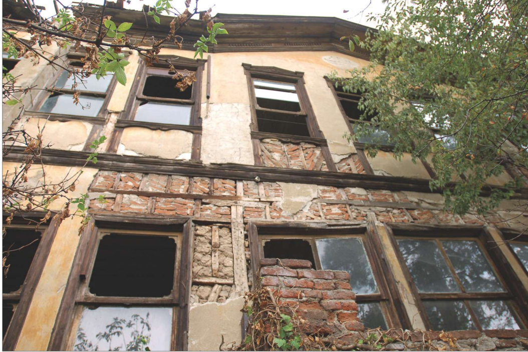
Res. 5. A yapısı doğu cephesi, taşıyıcı sistem (P.Kapar,2007)
