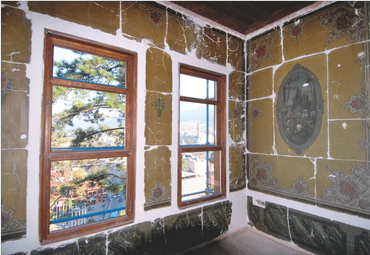
Res. 24b. A yapısı baş odada rekonstrüksiyon sonrasında yerine monte edilen kalemışı panolar
