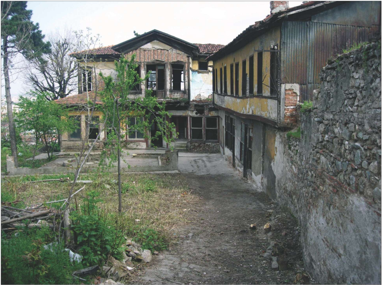
Res. 3. 1924 yıllarında yapılan A ve B yapıları (P.Kapar, 2006)
