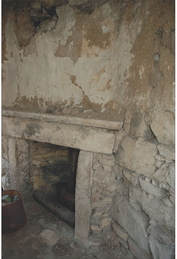
Fotoğraf 39 - 959 Parsel Ocak / Building lot: 959, fireplace
