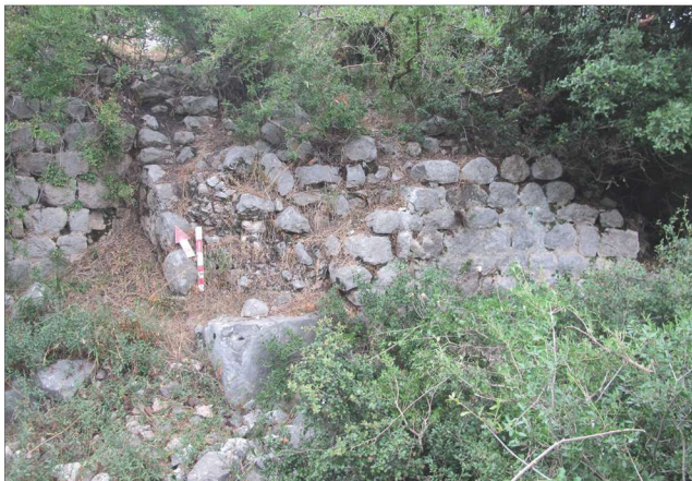
Fotoğraf 72 - Sumbas, Kızlaroturağı Kilise Güney Duvar / Sumbas, Kızlaroturağı Church south wall
