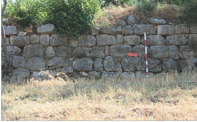
Fotoğraf 83 - Sumbas, Kırıkköprü Yapı 1 / Sumbas, Kırıkköprü Structure 1
