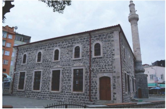
Fotoğraf 30 – Görele Hasan Ağa Camisi, genel görünüm (Fikret Ak; Görele, 2014) / The general view of Görele Hasan Ağa Mosque (Fikret Ak; Görele, 2014)
