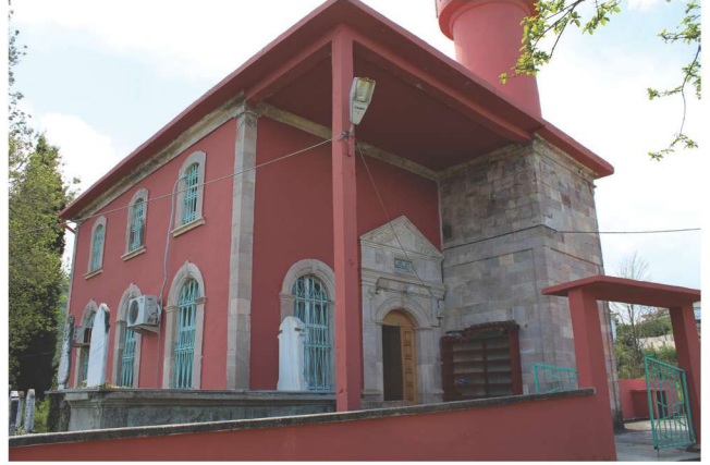
Fotoğraf 26 - Piraziz Gedikalizade Camisi, kuzey cephesi / The northern facade of Piraziz Gedikalizade Mosque
