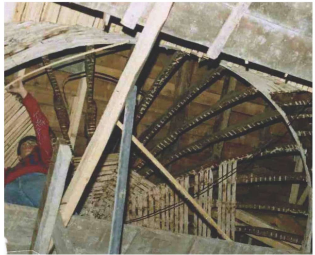
Fotoğraf 3 – Bağıdadi kubbenin bağıdadi çitalarının çakılması (Vakıflar Genel Müdürlüğü Arşivi'nden) / Nailing the timber laths of the bağıdadi dome (From the Archives of the General Directorate of Foundations)
