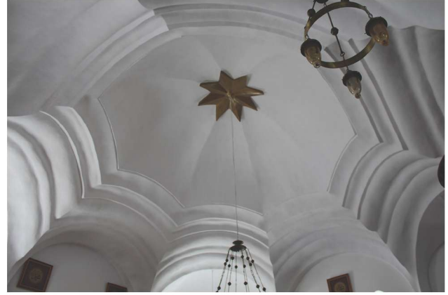
Fotoğraf 24 - Şebinkarahisar Tamzara Mahallesi Camisi, kaburgalı kubbe / The ribbed dome of Şebinkarahisar Tamzara Neighborhood Mosque
