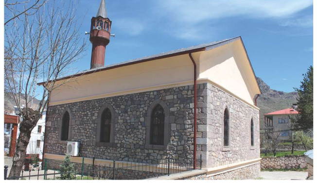
Fotoğraf 20 - Şebinkarahisar Tamzara Mahallesi Camisi, genel görünüm / The general view of Şebinkarahisar Tamzara Neighborhood Mosque
