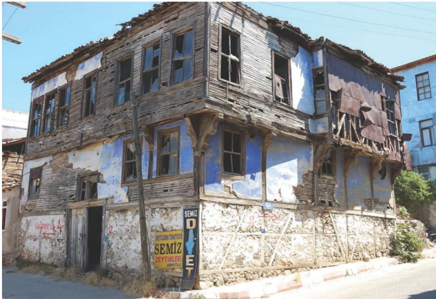
Fotoğraf 2- Evlerin üst kat cephelerinde bağıdadi tekniği ( http://www.yalovakentmuzesi.gov.tr ) / Bağıdadi technique used in the facades of the upper floors of the houses ( http://www.yalovakentmuzesi.gov.tr )
