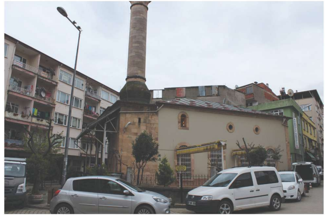
Fotoğraf 7 – Bulancak Eski Cami batı cephesi ve minaresi / The western façade of Bulancak Old Mosque and the minaret
