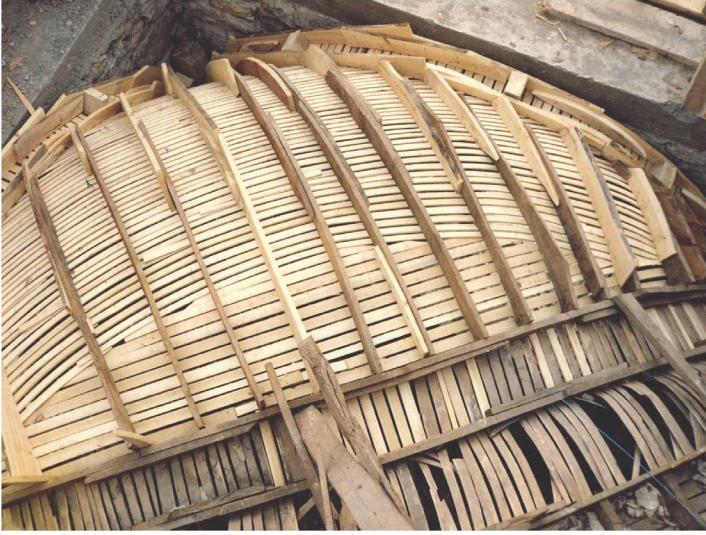
Fotoğraf 4 – Bağdadi tekniği uygulanan pandantif (Vakıflar Genel Müdürlüğü Arşivi'nden) / The pendentive with bağdadi technique (From the Archives of the General Directorate of Foundations)
