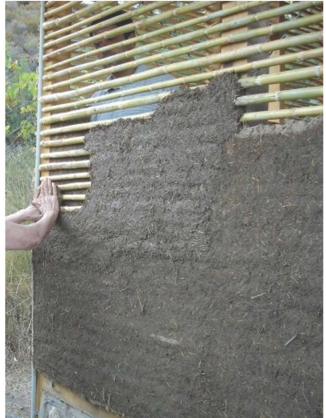
Fotoğraf 1 – Taşıyıcılara çakılmış kamışların toprak-saman karışımı malzeme ile sıvanması( http://bostancik.blogspot.com.tr ) / Plastering of the reeds nailed to the loadbearing elements with a mixture of earth and straw ( http://bostancik.blogspot.com.tr )
