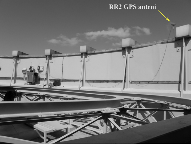
Şekil 12. Çatıda RR2 bağlantısı
