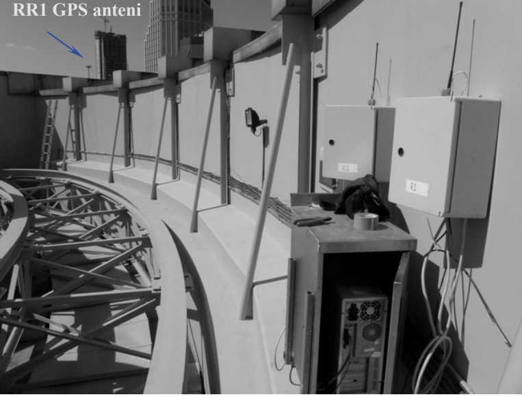
Şekil 11. Çatıda RR1 bağlantısı
