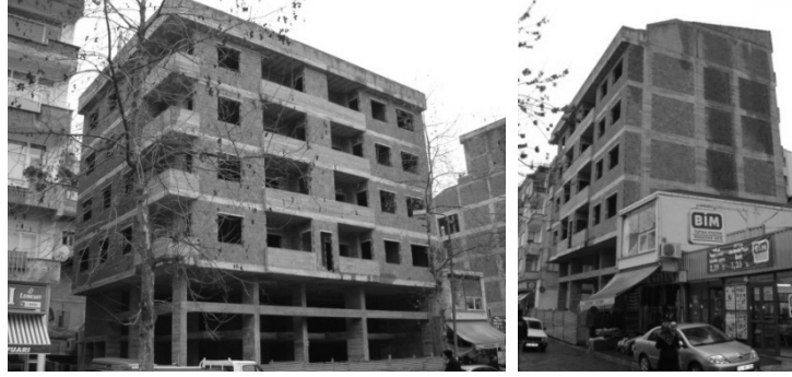
Şekil 2. Tuğlalı binanın farklı yönlerden görünüşleri.
