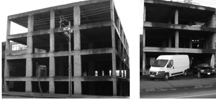
Şekil 1. Karkas binanın güney ve kuzey yönlerden görünüşleri.
