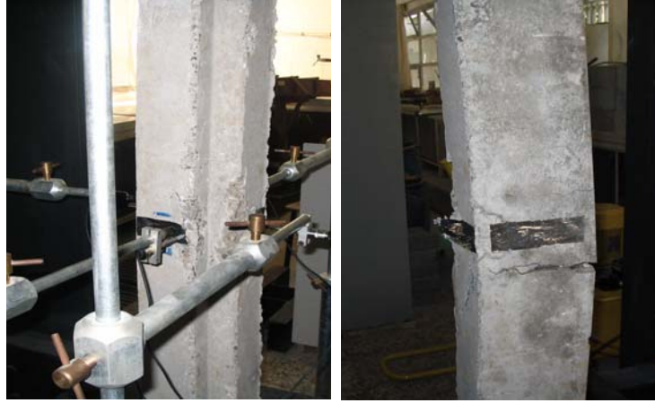
Şekil 7. Betonarme kolon kırılma biçimi
