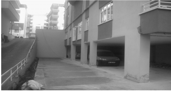
Resim 1. Bina cephesinden daha uzun istinat duvarlı bina örneği
