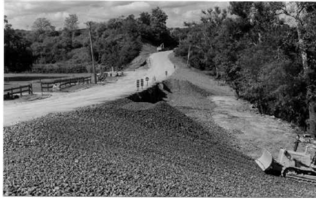
Şekil 2. Havada soğutulmuş kırma-cüruf ile yol inşaatı çalışması
