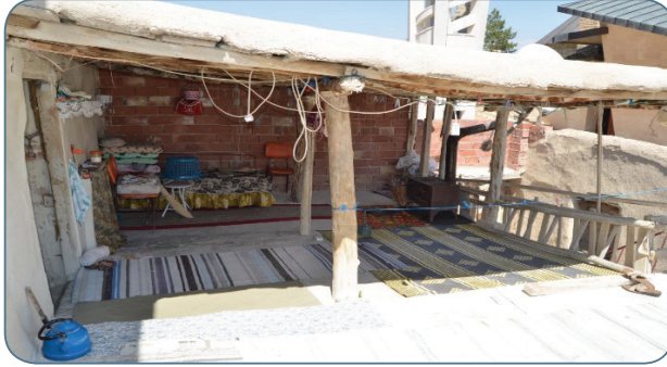
Şekil 5. Balaban geleneksel yerleşim dokusunda bulunan bir yapıda yarı açık oturma birimi
