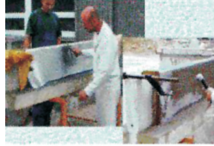
Resim 26: Kolonun tekstil malzemesiyle güçlendirilmesi [5]
