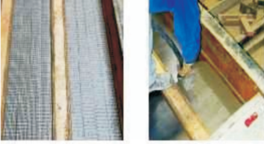
Resim 32: Tekstil takviyeli kompozit beton panellerin üretimi [9]
