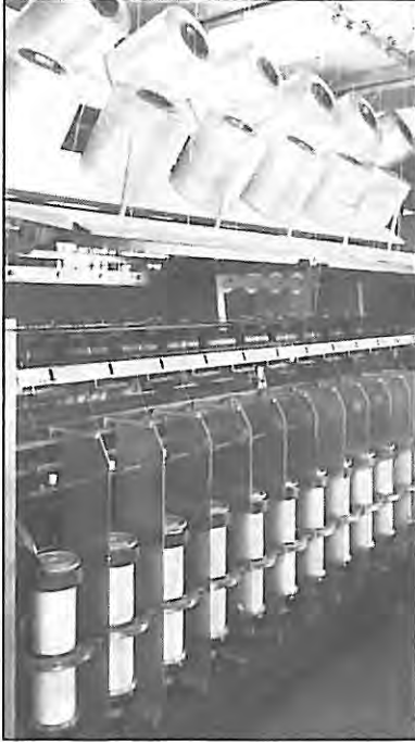
Resim 71. AZB universal bilezikli büküm makinası
