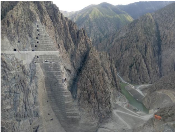
Şekil 2. Çalışma sahası Artvin-Yusufeli barajı
