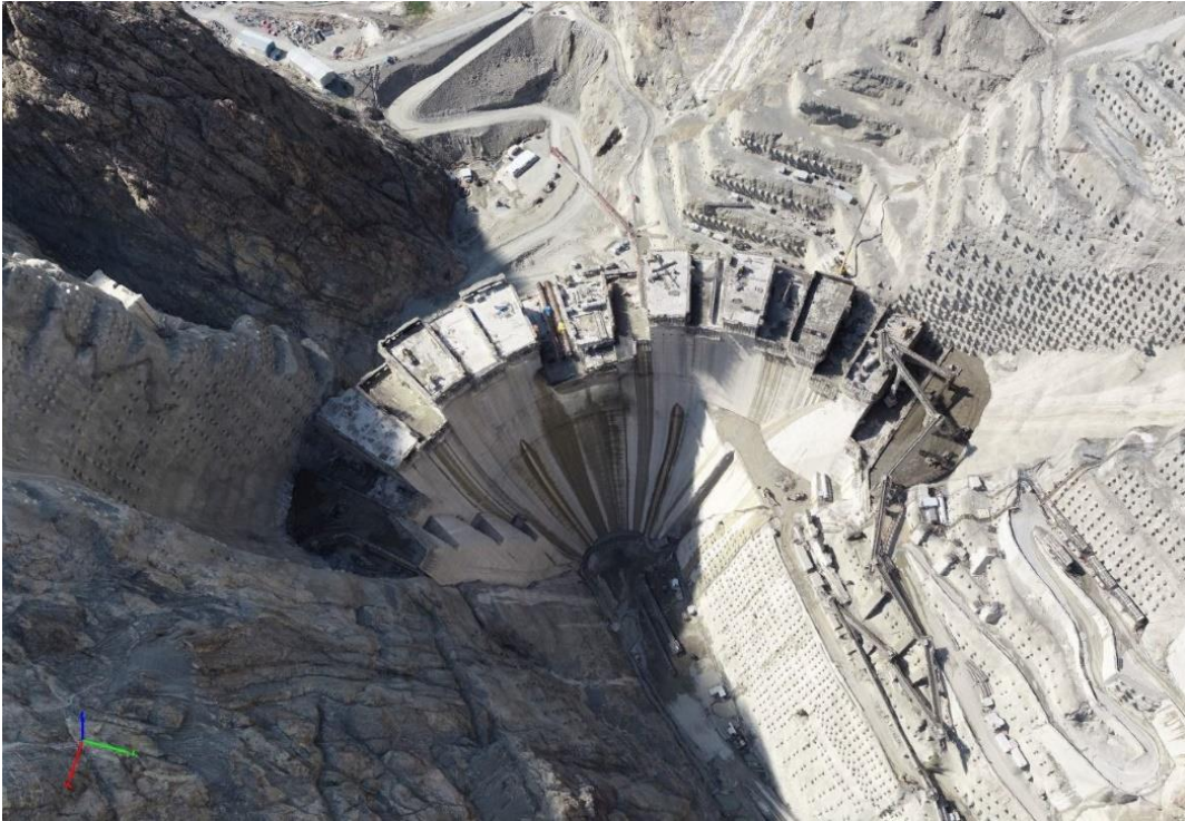
Şekil 10. Çalışma sahası doku kaplama
